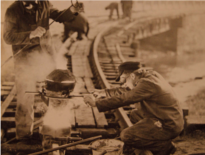
Das Foto „Schienenbruch wird behoben“ von Gottfried Münch, wurde 1963 von der LVZ mit einem Preis bewertet.
